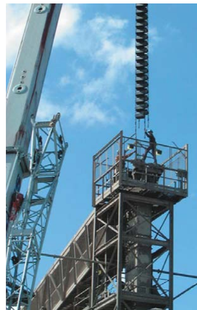
Abbildung 17: einfache und schnelle Montage eines Endloskettenstrangs
